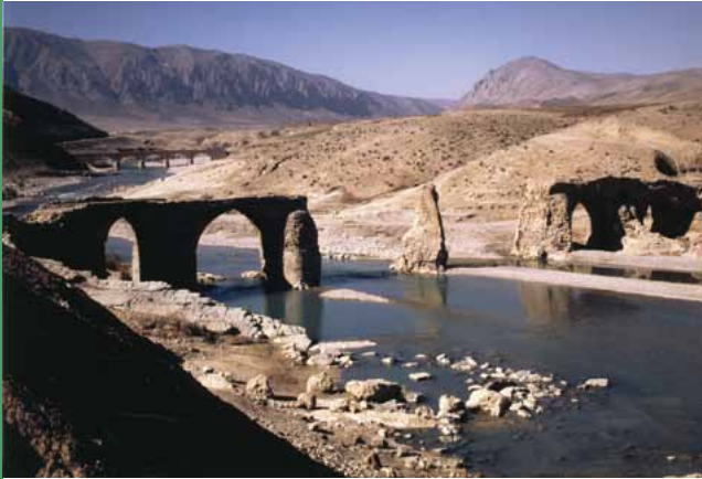
南イランのクヴァール川に架かる サーサン朝時代の橋梁址（1987年1月）。
