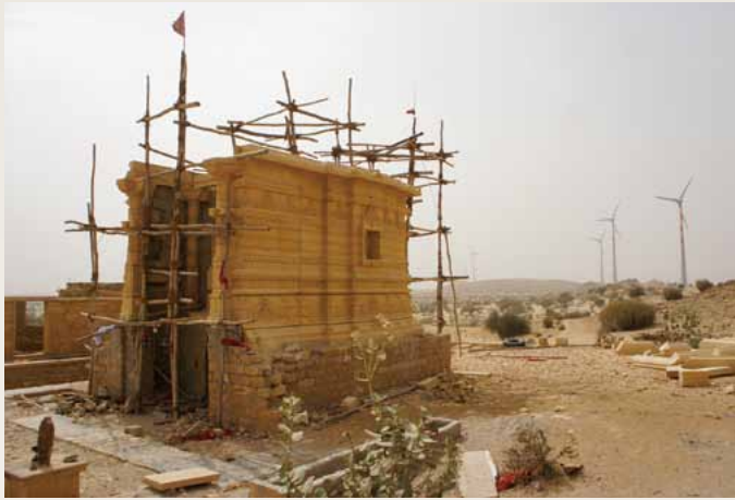
風車の建設と同時期に始まった周辺地域の寺院の改修・改築ラッシュ。関連性はあるのか。
