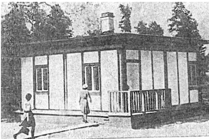
図1：パネルを用いた小型住宅の例 《Архитектура СССР》1944. №6. С. 28より抜粋
