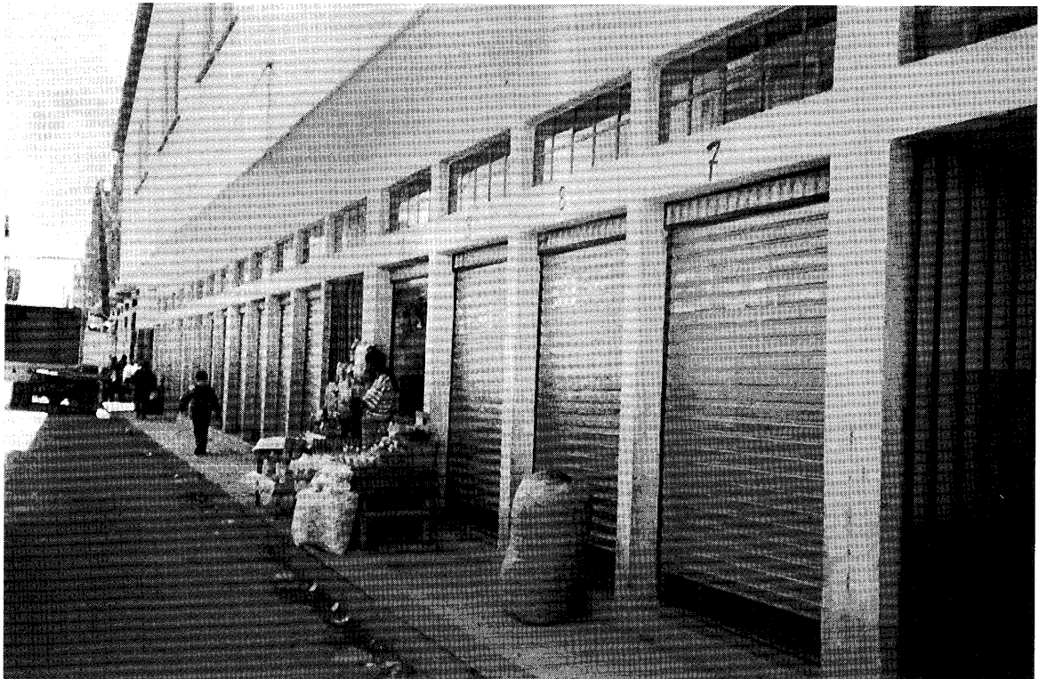
写真6 鉄筋コンクリート製の市場 97年に大衆参加法の予算で建設されたが、1階の一部を除きほとんど使われていない
