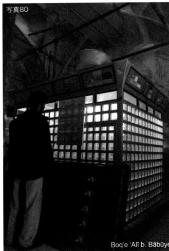
写真80 Boq'e 'Alī b. Bābūye。ハラム内は改修中のため、床がはがされ、足場が組み立てられ、外した扉や建築資材が置かれているが、ズイヤーラトのために訪れる人は多い。
