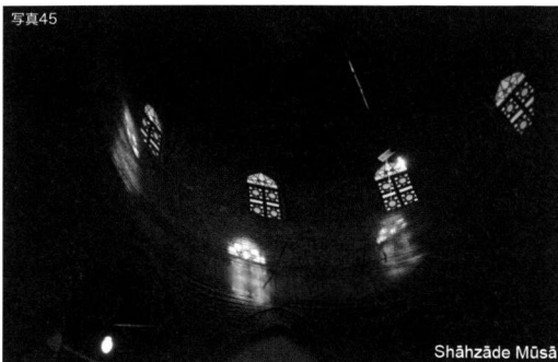
写真45 Shāhzāde Mūsā。ドーム内部。まだ色ガラスが入っただけで煉瓦がむき出しのままだが、アーイーネカーリーで飾るつもりであるとのこと。
