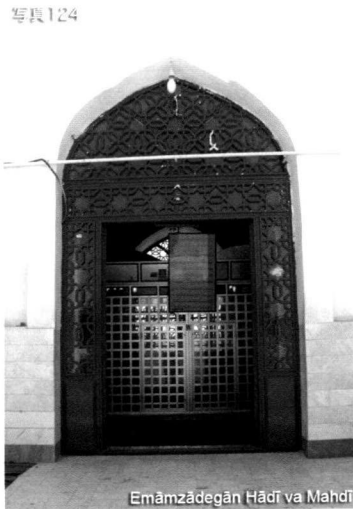
写真124 Emāmzādegān Hādī va Mahdī。 向かって左手の廟。三方向からハラムに入れるが、これは廟に向かって右手の入り口から。
