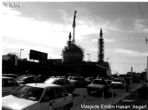
写真64 Masjede Emām Hasan 'Asgarī。現在、Emānzāde Seyyed Nāser al-Dīnとは道路を挟んで向かい側に建つ。大規模な建築工事中。ハラムに近いこともあり、周囲はいつも人と車で混み合っている。
