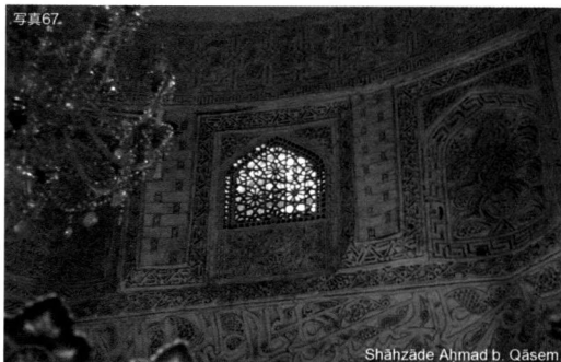
写真67 Shāhẓāde Ahmad b. Qāsem。ハラム内に施されたギャッチボリー。最近、修復が行われ、その際に、光沢のある真っ白なペンキで塗られてしまった。
