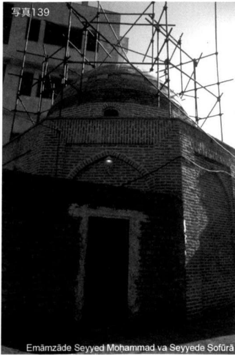
写真139 Emāmzādegān Seyyed Mohammad va Seyyede Šafūrā。大規模改修中。ドームはタイルがほとんど落ちてしまっていたのを新たに張り直し、壁もほぼ全面的に修復された。
