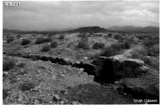
写真271 Shāh Qāsem。ガナートの出口。ガナートの出口に向かって左上部が以前の廟の跡。少し土が盛り上がって見える部分が、以前壁だったところと思われる。
