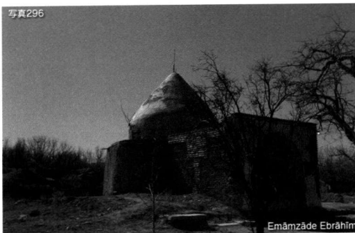
写真296 Emāmzāde Ebrāhīm。補修の跡は見られるが、あちこちいたみも目立つ。廟の向かって左手から裏にかけて建てられていた日干し煉瓦の建物はすっかり崩れ、墓地との間の土堀も何カ所か崩れてしまっている。
