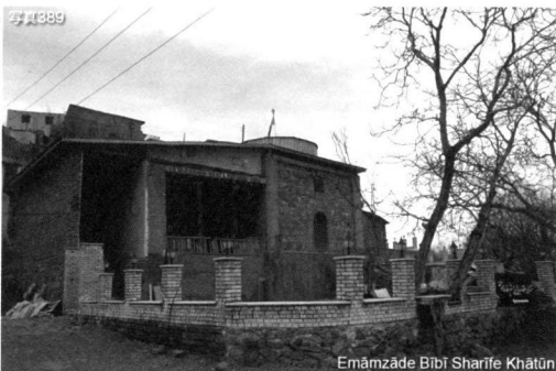
写真389 Emāmzāde Bībī Sharīfe Khātūn. 大規模改修が行われている最中で、ドームは基礎部分があるもののドームそのものはまだ作られていない。また、廟を取り囲む柵を作るための作業が進行中。これらの作業のため、廟の周囲に広がっていた墓のうち、古いものが取り除かれ、積み重ねられたり、資材として再利用されたりしていた。
