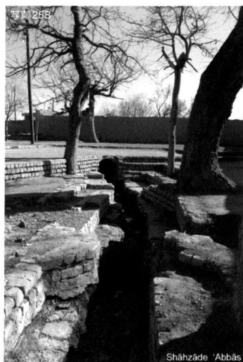
写真258 Shāhẓāde 'Abbās。廟内を通る水路。カナートを通ってきた水がここから周囲のバグへと流れて行く。
