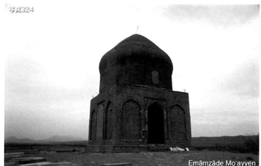
写真324 Emāmzāde Mo'ayyen。ハラム部分とは不釣り合いな大きなドームを持つ廟。屋根から突きだしている鉄筋や、煉瓦のままの外壁などまだ工事が終わっていないように見える。
