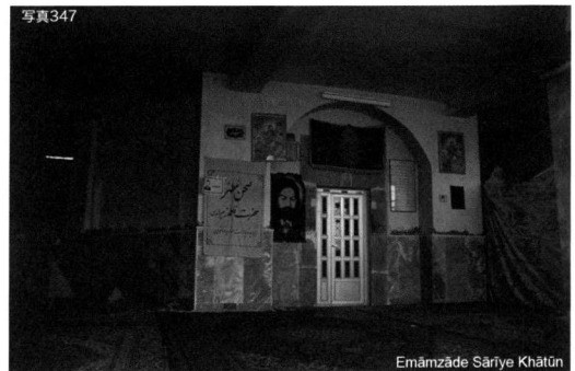
写真347 Emāmzāde Sāriye Khātūn. 古い廟に建て増しを行って、古い部分をそのまま部屋として取り込んでいる。ハラムは以前、塔状の建物として独立して建てていたものが、六角形の部屋として廟内にそのままの形で残されている。
