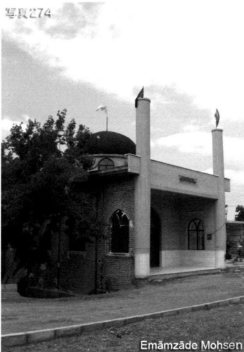
写真274 Emāmzāde Mohsen。廟脇のガナート出口側から。新しく建てられた廟だが、前面はタイルが貼られたものの、側面はまだ芯の煉瓦や鉄骨がむき出しのまま。
