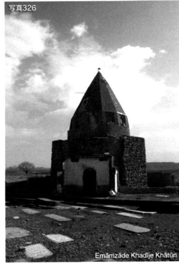
写真326 Emānzāde Khadije Khātūn. 廟の正面から。ドームのタイルはほとんど剥落し、入り口前のファサード部分も取り壊されている。改修のための資材は墓地の一角に置かれているので、工事が始まるのではないかと思われる。
