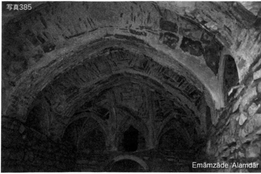
写真385 Emāmzāde 'Alamdār. 入り口前のファサード上部。石を組み合わせ、漆喰でつないでいるもの。修理が行われたばかりなので漆喰がまだ白い。こういった石積みのお廟は時々見かけるが、こうした凝った作りのものは案外少ない。
