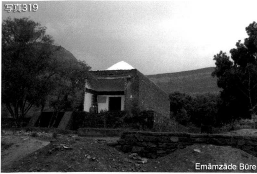
写真319 Emāmzāde Būre。廟の建つ一角の周囲はバークが広がっているが、廟の周囲はハウスを作ったり、ズィヤーラトの人々のための施設を建てるため、土が掘り返されたり煉瓦が積まれていたり、雑然とした様子。
