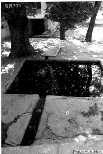
写真393 Emāmzāde Hādī。廟の建つ場所より一段低くなった場所には、アーバンパールとハウスが作られている。この水はガナートで引かれたものとのこと。この水は、廟の中をめぐった後、周囲のバークへと導かれていく。
