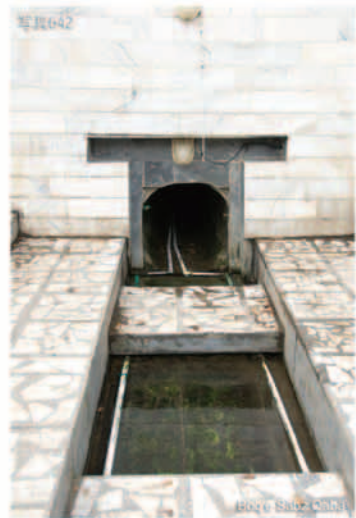
写真642 Boq'e Sabz Qabā. 水の湧き出し口。以前は溢れるように水が湧いていたが、この数年、水量が減ってしまった。水路に見える白いパイプは水道のためのもの。
