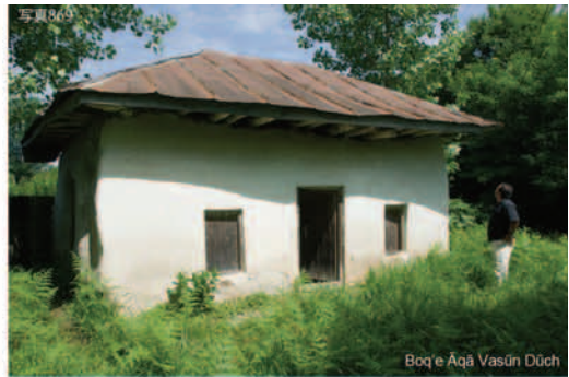
写真869 Boqe Aqa Vasun Duch. 草と木に囲まれた廟。外側は、入り口の扉が閉まらなくらいで、それほど傷んでいるようには見えない。
