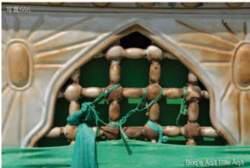
写真666 Bo'q'e Aqā Pile Aqā. ザリーの一部。屋外にあるため、錆が浮いているが、ダブルが結ばれ、信心を持つ人がいたことを示している。しかし、全体に新しいダブルは少ない。村の女性たちによると、信心を持つ人も多いということである。
