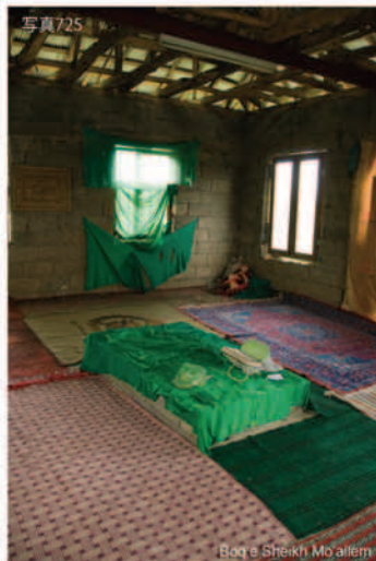
写真725 Boq'e Sheikh Mo'alem. コンクリートブロックがむき出し、天井も骨組みがむきだしのまま、窓も一部はガラスが入っていない状態の廟内の中央に、コンクリートブロックで作られた墓石が置かれている。
