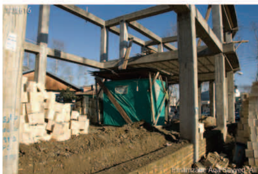
写真616 Emānzāde Āqā Seyyed 'Alī. 工事中も、ズィヤラトの人たちのため、ザリーはそのまま、埃よけ雨よけのため、仮の屋根をかけて工事現場に置かれている。工事中ではあるが、この地区の人たちはそれまでと同じく訪れるとのこと。
