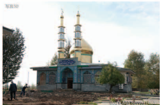
写真50 Boq'e Āqā Seyyed Hasan. 2013年春に訪れたときには、ドームとゴルダステが金色の金属に変わっていた。また、墓地も整備のために墓石をはがし、整地を行っていた。これまで土がむき出しだったのを、ブロックタイル張りにするのだという。何本もの短い杭が立っているのが見えるのは、墓石が置かれていた場所を示すためのもの。墓石を戻すための目印。
