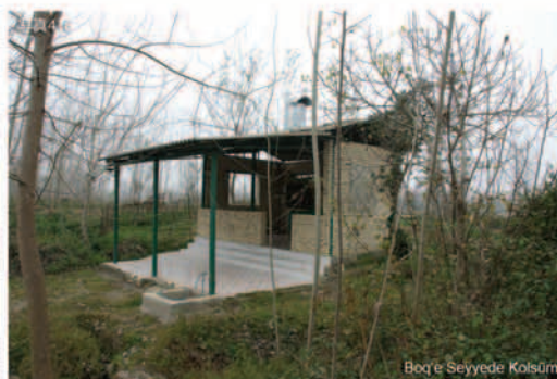
写真416 Boq'e Seyyede Kolshūm. 村はずれに新しく建てられた廟。とはいえ、壁がまだ中途半端で、廟前面では壁の高さが半分以下であったり、屋根との間に隙間が残っていたり、窓にガラスが入っていないなどいろいろ。いつ完成するのかについては、予算がきたらとのことであった。
