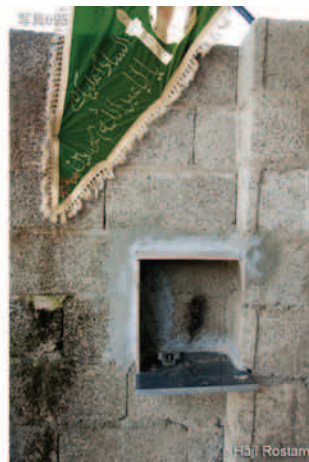
写真695 Boq'e Hājī Rostam, 廟の入り口脇に設けられたシャムダーン。シャムダーン脇に眠鳩の煤が見られるので、以前そこをろうそくが灯されていたのを、シャムダーンを設けることでコントロールしようとしたものと思われる。
