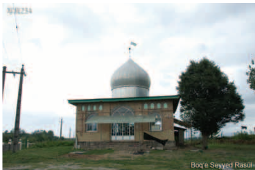
写真234 Boq'e Seyyed Rasul. 銀色の大きなドームを持つ新しい廟。まだ工事は完全に終わっておらず、廟内などまだ工事が続いている。
