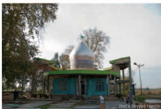
写真169 Boq'e Seyyed Hamid. 増改築が進んだ廟。ドームがタイル張りから銀色のものになっている。近年、設置が容易で雨に対する耐久性もあり、また見栄えもする金色や銀色のドームを持つ廟が増えている。
