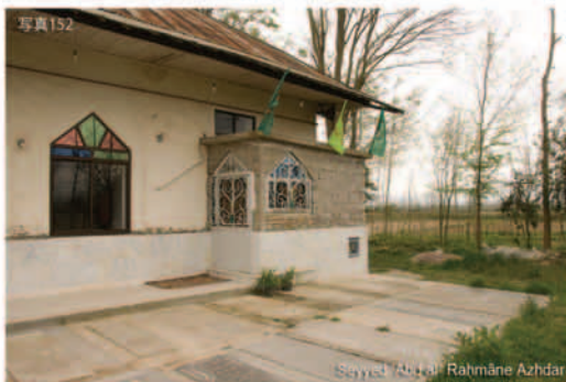
写真152 Boq'e Seyyed 'Abd al-Rahmāne Azhdar. あとから付け加えたことが明らかかな廟の入り口。本来は建物に入り口があったのだが、靴を脱ぎ、預けるための場所を作るために、外側に新しく空間を付け足すことになったことから、このような形になった。
