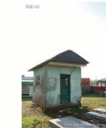
写真145 Boq'e Aqā Seyyed Ebrāhīm. 細長い建物のこの部分だけを切り落としたような廟。土台は崩れかき、壁もひびが入るなど、傷みが目立つ。
