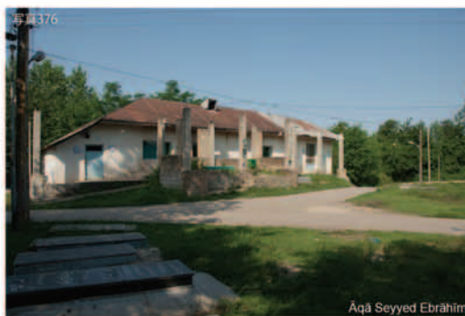
写真376 Aqâ Seyyed Ebrâhim. マスジェドと、道路を挟んで広がる墓地の間に土台と柱だけつけられ放置されている廟が見える。工事が途中で止まっているのは、集められた資金を持ち逃げされてしまったため。
