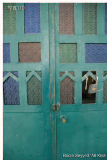
写真110 Boq'e Āqā Seyyed 'Ali Kiyā. 鍵の近くのガラスが外してあり、そこから手を入れて鍵を開けることができるようになっている。日が落ちると写真右に見える南京錠をかける。
