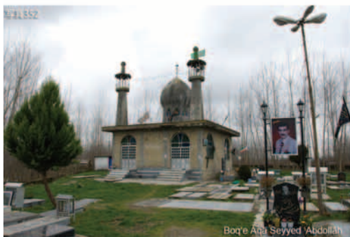
写真352 Boq'e Āqā Seyyed 'Abdollah. 墓地の中に建つ新しい廟。ドームはコンクリートのままで、外壁も煉瓦がむき出しのままである。工事が行われている様子はないので、しばらくはこのままなのかと思われる。また、入り口が二箇所あるので、男女が分けられているのかと思ったが、向かって右側の入り口だけが開けられていた。
