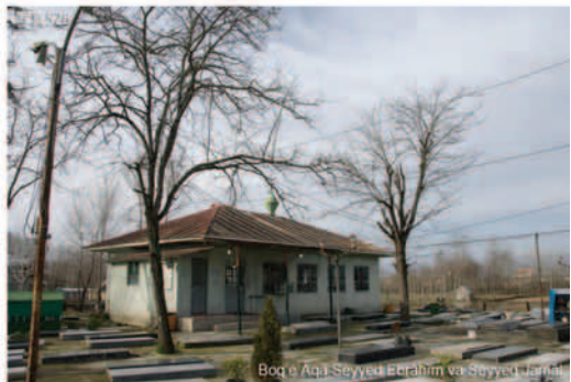
写真528 Boq'e Aqâ Seyyed Ebrâhîm va Seyyed Jamâl. 墓地を挟んでセイエド・ジャマールと向き合って建つ廟がセイエド・エブラーヒーム。屋根の上の黄緑色のゴンバドが乗っていないければボクエには見えない。
