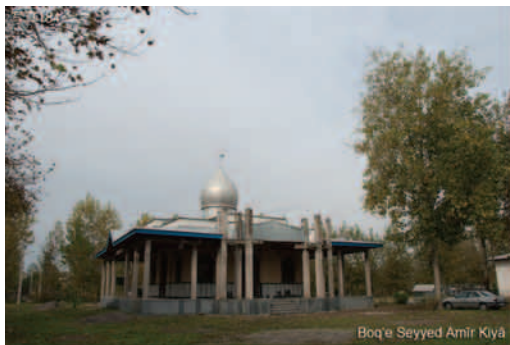
写真184 Boq'e Seyyed Amir Kiyā. 廟を拡張するために、現在の廟の外側に柱を立てている。現在の廟も、建てられたのは最近のことだが、再度、拡張工事が始まった。
