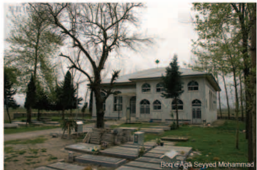
写真155 Boq'e Aqā Seyyed Moḥammad. L字になったマスジェドの、写真右手、窓が二層になっている部分がマスジェド、左手の空間が廟となっている。
