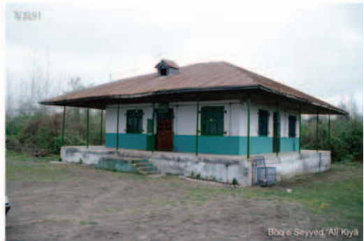
写真91 Boq'e Seyyed 'Ali Kiyā. 海岸に近い場所にあるため地面は砂に。廟の周囲も砂の小山が連なっている。廟はエイヴァーンを四方にめぐらせているが、他の廟で多く見られるようにそこでつろぐための空間ではなく、通路。
