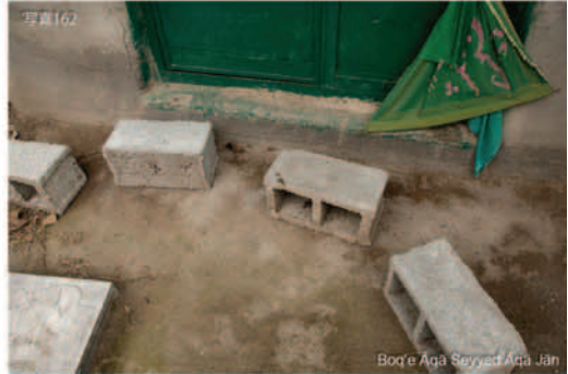
写真162 Boq'e Āqā Seyyed Āqā Jān. 扉の前に並べられたコンクリートブロック。一部、ブロックの中でろうそくを灯した跡が見られる。
