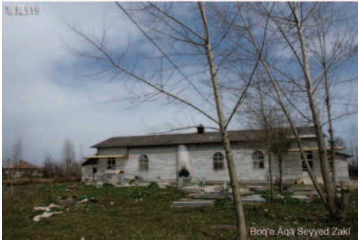
写真519 Boq'e Aqā Seyyed Zaki. 村の住宅が並ぶ地区の中、大きなマスジェドの一部。以前は、ノマニーと呼ばれる大型で神聖なゴルアーンが置かれていたが、現在はヘイアトル・オマナーの家に保管されているというので、見せて欲しいと申し入れたところ、シャベ・ガドルにしか公開しないということで、見ることはできなかった。
