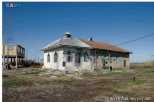
写真311 Boqe Aqā Seyyed Jalīl. マスジェドと一体になった廟。外壁や屋根の色が完全に違っているので、別々に建てられたものであることが分かる。マスジェドの方は、コンクリートの壁がむき出しのままである。
