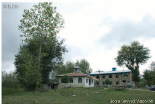
写真238 Boq'e Aqā Seyyed 'Abdollah. 村の端、墓地が広がる中に建つ白い廟。廟の後ろは建設中のマَسْجِد。周囲には水田が広がる。
