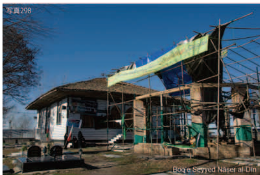
写真298 Boq'e Seyyed Nāser al-Dīn. 廟の前に建っていた歴史的建造物のタズィイーエ・ハーニーは解体修理中。敷地内のマズジェドを含め、歴史的建造物が集まっていた。
