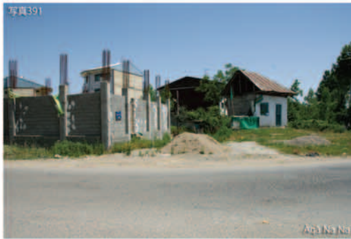
写真391 Āqā Na Na. 現在建築中のマスジェドとアーガー・ナ・ナ。マスジェドの入り口（予定）の前にはろうそくを灯した跡が見られるが、理由は確認できなかった。
