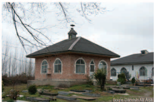
写真537 Boq'e Darvish'Ali' Aqā. 村はずれに広がる墓地の中。写真奥はマスジェド。つい最近建て替えられたばかりの廟。外壁はまだ工事が残ったままで、窓枠の隙間を埋めるための漆喰が白く残っている。
