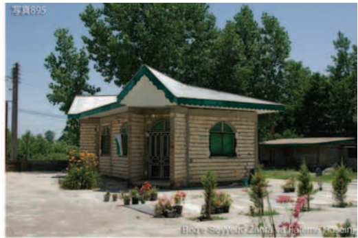
写真895 Bo'q'e Seyyede Zahrâ va Fâteme Hoseinî. 二方向に出入口を持つ新しい廟。外壁の工事はまだ行われていない。
