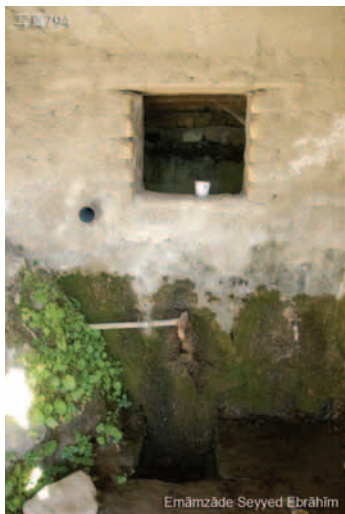
写真794 Boq'e Aqâ Seyyed Ebrâhim, 小屋の中。壁を四角く切つてある向こう側は大きな水槽。その水をこちら側の蛇口から使用する。
