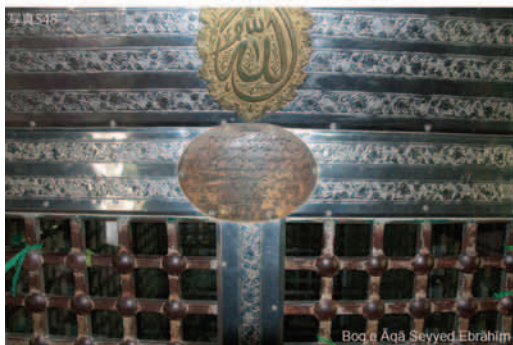
写真548 Boq'e Āqā Seyyed Ebrāhīm. ザリーはスィヤラトの人たちが触れ続けられたため、地金が出てしまっている。中央の楕円のプレートには制作に関する銘文。
