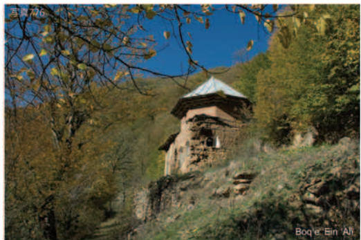
写真776 Emāmzāde 'Ein 'Alī. フォーマン・マースレー街道沿いの斜面の上。角錐ドームを持つ廟が建っている。
