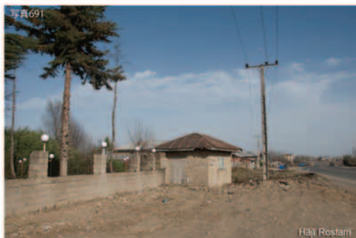
写真691 Boq'e Hāji Rostam. マスジェドの敷地を示す柵から民を出した、小さな建物がある。
