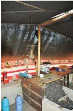
支柱の下部はかまどの燃料糞置き場の中央に埋まっている
