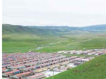
町の外れに建設された移民村
